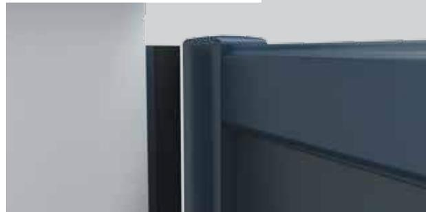
**3** U de réception avec système « anti-dégondage » (pour éviter le soulèvement du portail en position fermée) fourni de la couleur du portail.
